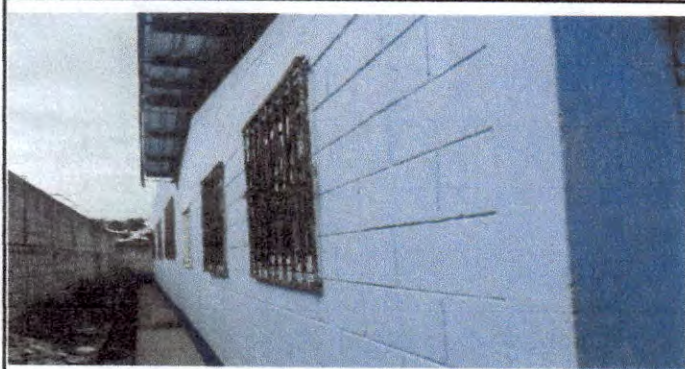
Foto 3: PINTURA DE PARED, EXTERIOR MODULO DOS.
