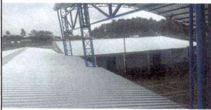
Foto 1: CAMBIO DE LAMINA DE ZINC, POR LAMINA TROQUELADA, EN MODULO UNO, DE TRES AULAS.
