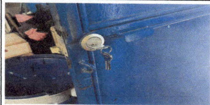
Foto 5: CAMBIO DE CHAPAS EN CINCO PUERTAS, DE DIFERENTES AMBIENTES.
