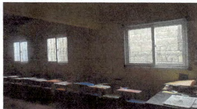
Foto 8: COLOCACIÓN DE VENTANAS DE PVC, EN AULA DE PRIMER GRADO.
