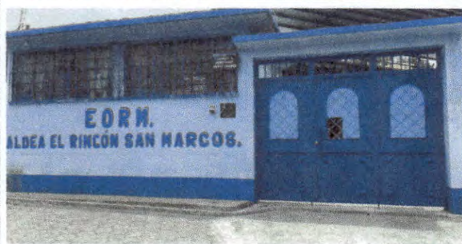
Foto 7: INSTALACION DE PORTÓN PRINCIPAL DE TRES HOJAS.
